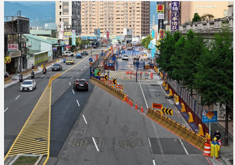
環狀線北環段CF680B區段標工程
