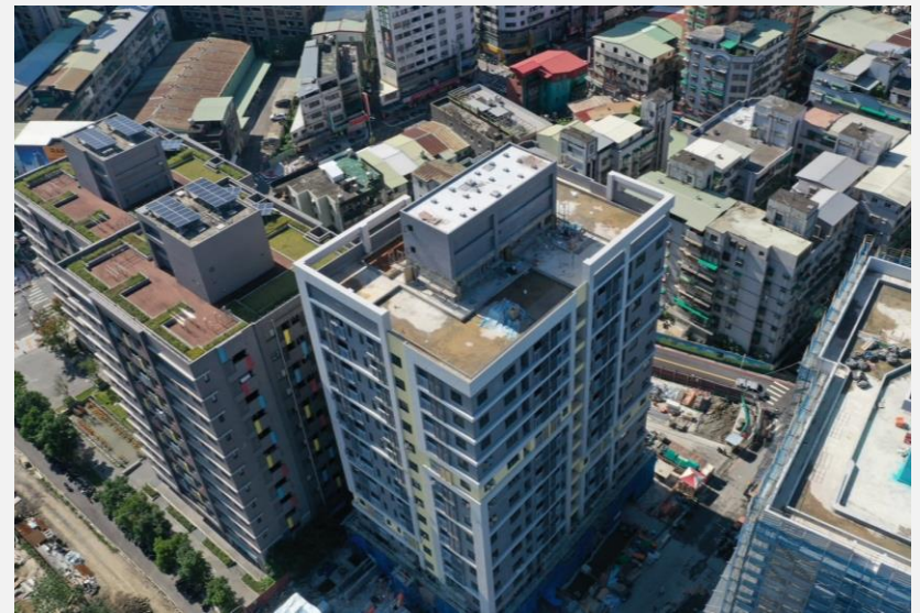
三峽國光段（二期）青年社會住宅新建統包工程
