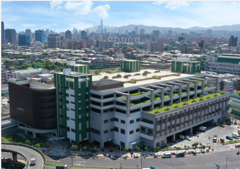
臺北市市場處所屬公有環南市場改建工程主體工程
