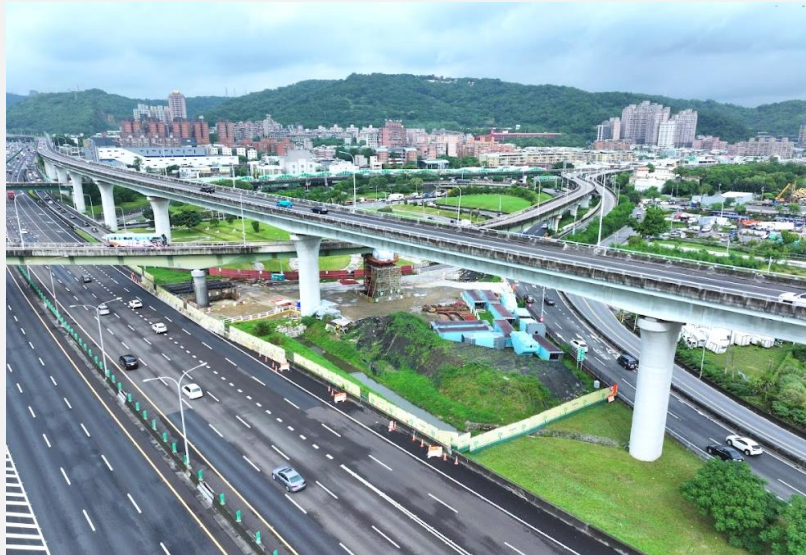
國道1號五股交流道增設北入及北出匝道改善工程(第I103S標)
