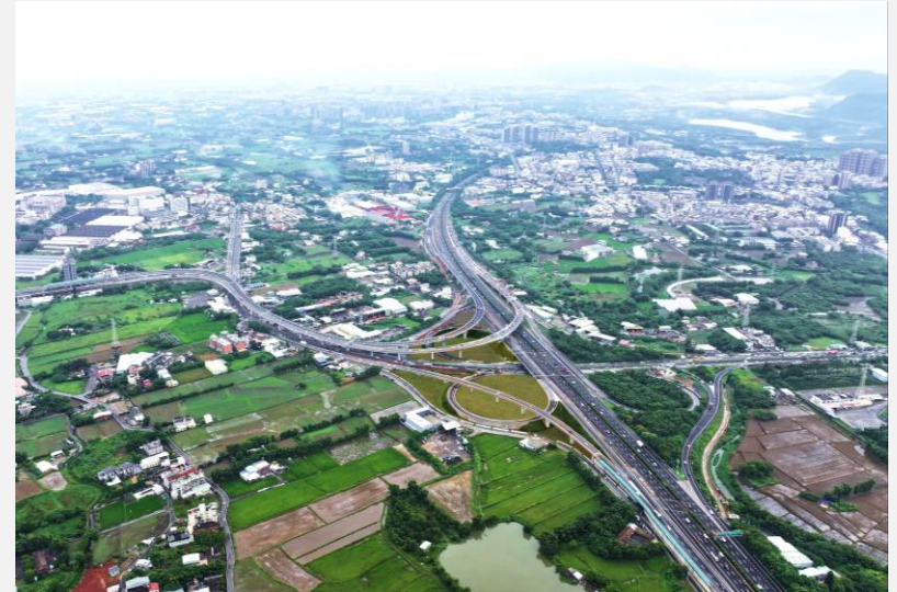
國道3號銜接台66線增設系統交流道工程(第336標)
