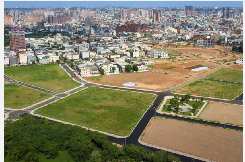
桃園市中壢運動公園區段徵收工程
