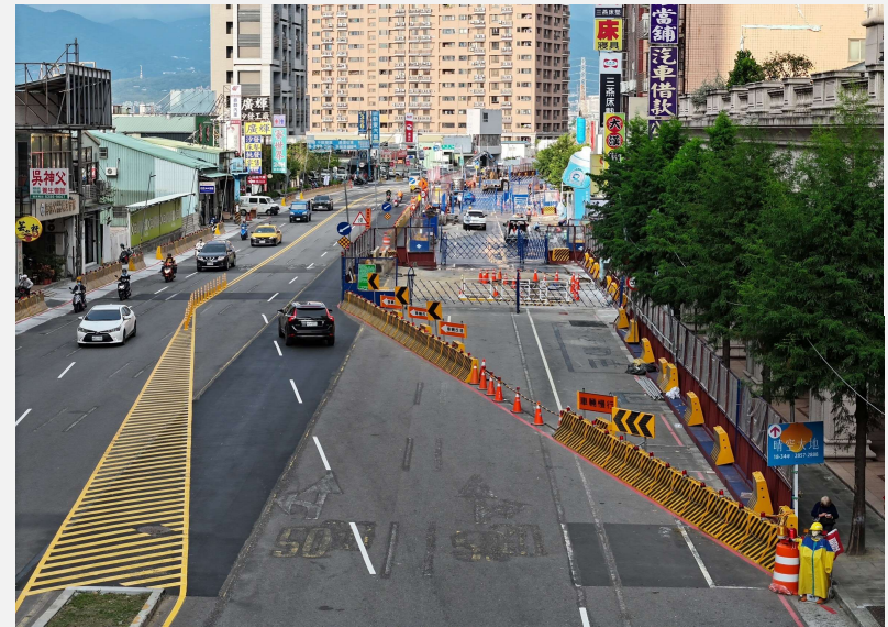
環狀線北環段CF680B區段標工程
