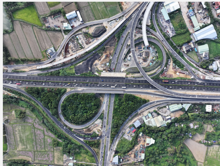
國道3號銜接台66線增設系統交流道工程 (第336標)
