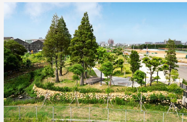
桃園市中壢運動公園區段徵收工程
