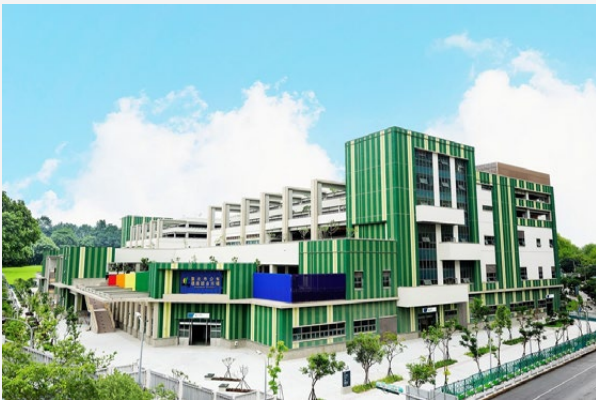
代辦臺北市市場處所屬公有環南市場改建工程 主體工程
