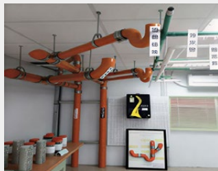
水電配管工法示範
