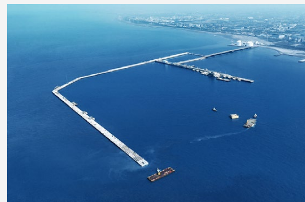
觀塘接收站外推方案之外廓防波堤新建工程
