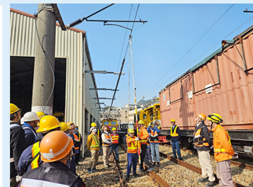
▲ 鐵道沿線施工安全接地及斷電作業人員實務技能教育訓練
